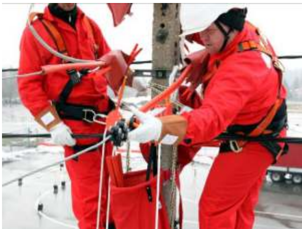
Рис.3 Установка монтажного зажима Н022 на проводе для натяжения полиспастом
