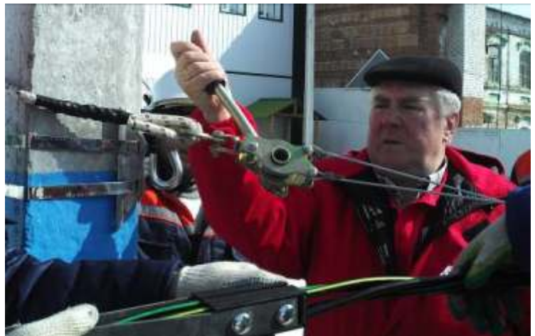
Рис.5 Натяжение провода лебедкой ЛР-1500
