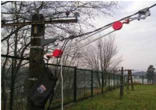
Установка монтажного зажима на проводе для натяжения лебедкой ЛР-1500
