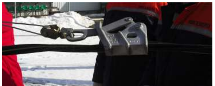
Установка монтажного зажима на проводе для натяжения лебедкой ЛР-1500
