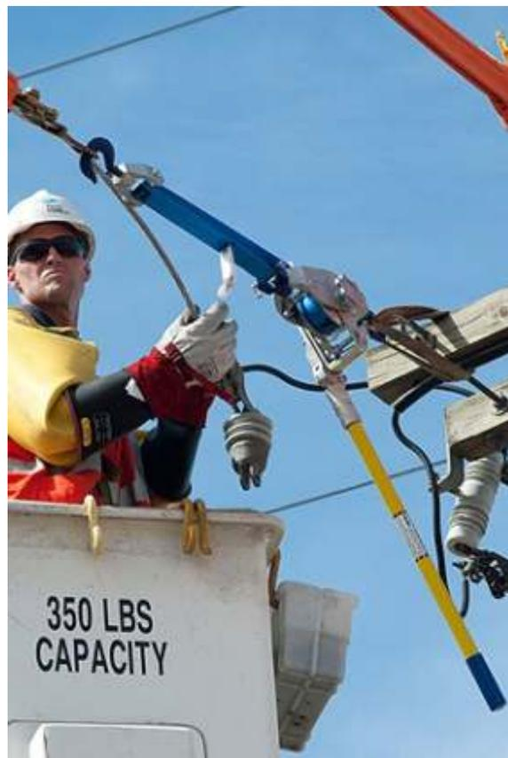
Натяжение провода лебедкой типа SEWS 1500 с капроновым диэлектрическим канатом для работ на воздушных линиях до 15кВ, под напряжением
