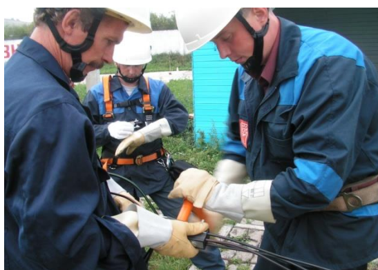
9. Установка зажима на земле
