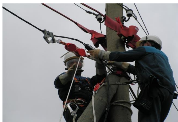
10. Установка зажима на опоре
