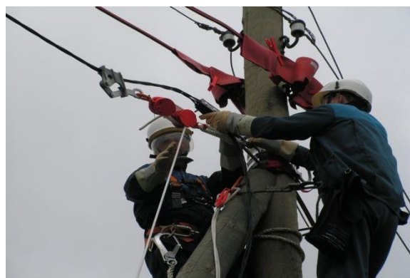
8. Установка зажима на опоре
