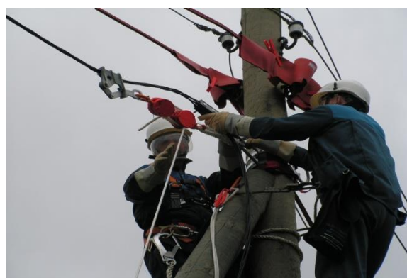
8. Установка зажима на опоре
