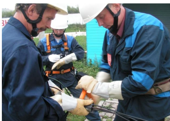
7. Установка зажима на земле
