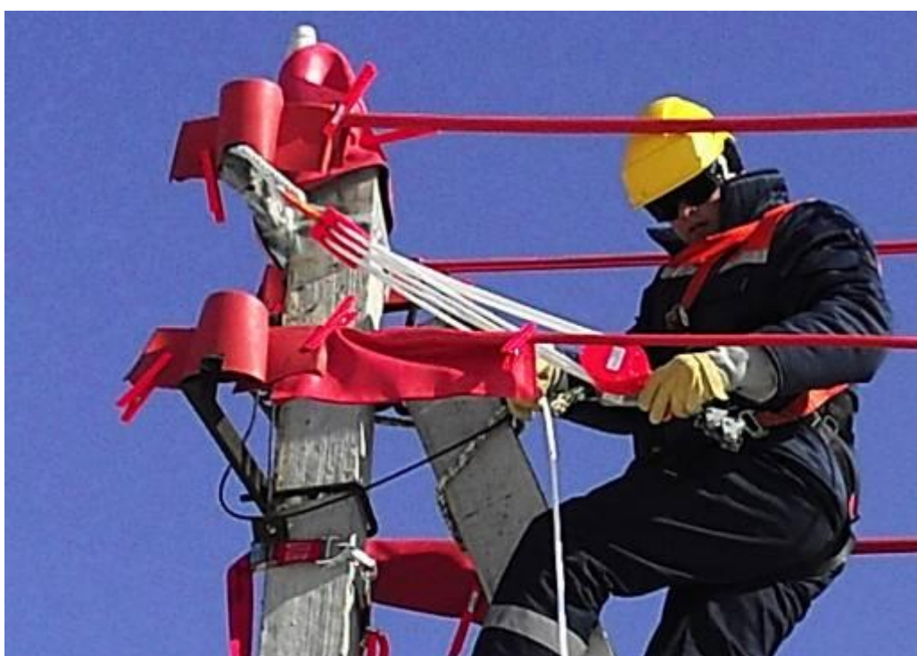
Рис.3 Крепление блока полиспаста на опоре
