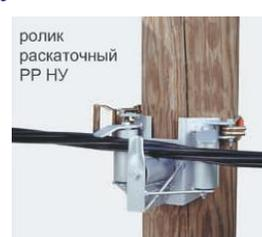
3. На угловых опорах, где угол излома линии проходит с внешней стороны опоры, чаще всего при строительстве ВЛИ с двумя параллельными жгутами СИП (обычно там монтируют крюки наружного угла **КНУ-1, КНУ-2**), развешивают ролики специальной конструкции **РР НУ**.
