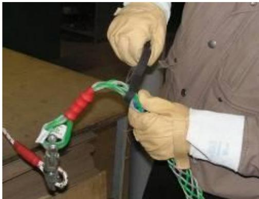
Чулок надевается на жгут СИП, и через вертлюг и фиксатор крепится к тросу-лидеру (канату) сечением минимум 10мм.
