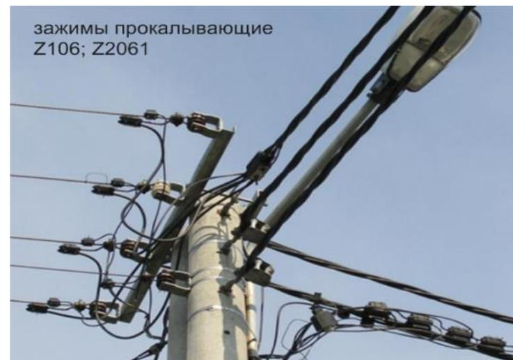
3. Прокалывание изоляции должно произойти таким способом, чтобы в образовавшиеся отверстия в последствии, к алюминиевым жилам не проникала вода. Иначе говоря, прокалывающие зажимы должны быть достаточно герметичными.
