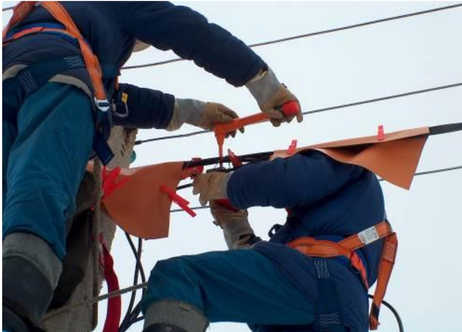
8. Герметичные, прокалывающие изоляцию СИП зажимы типа **PC 25, PC 95, PC 95-10, PC 4-150, PC 35 -150, NF 2,5-150, NF 25-150** применяются для присоединения к магистрали ВЛИ линейных ответвлений (участок линии, имеющий более двух пролетов) или ответвлений к вводу (участок от опоры магистрали или линейного ответвления до зажима ввода).
