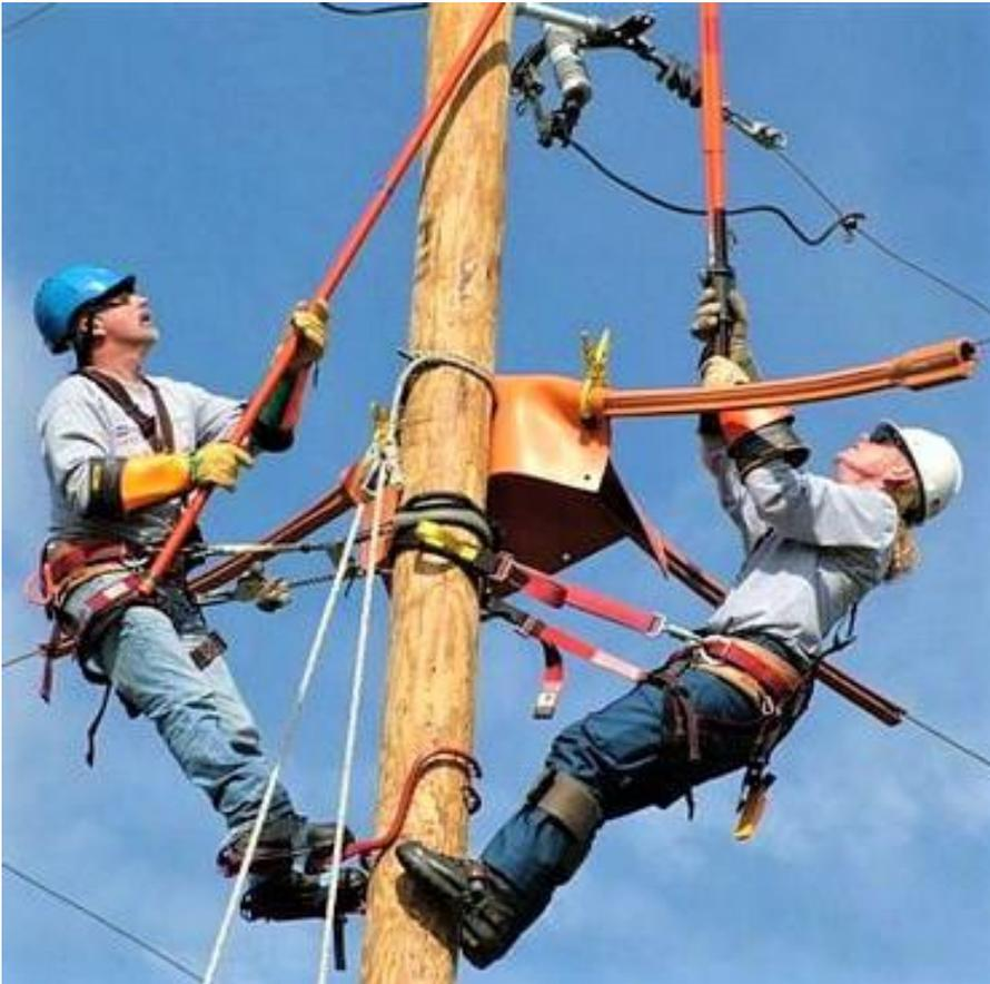
Установка шунта SHI-10SHUP (AC-AC) на ВЛ-10кВ методом «на расстоянии» с применением штанг изолирующих оперативных типа SHU и SHUP35
