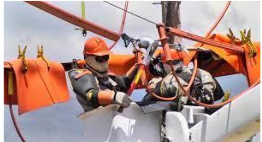
Установка шунта SHI-10SE (AC-AC) на ВЛ-10кВ методом «в контакте» с применением изолирующих средств индивидуальной защиты класса 2
