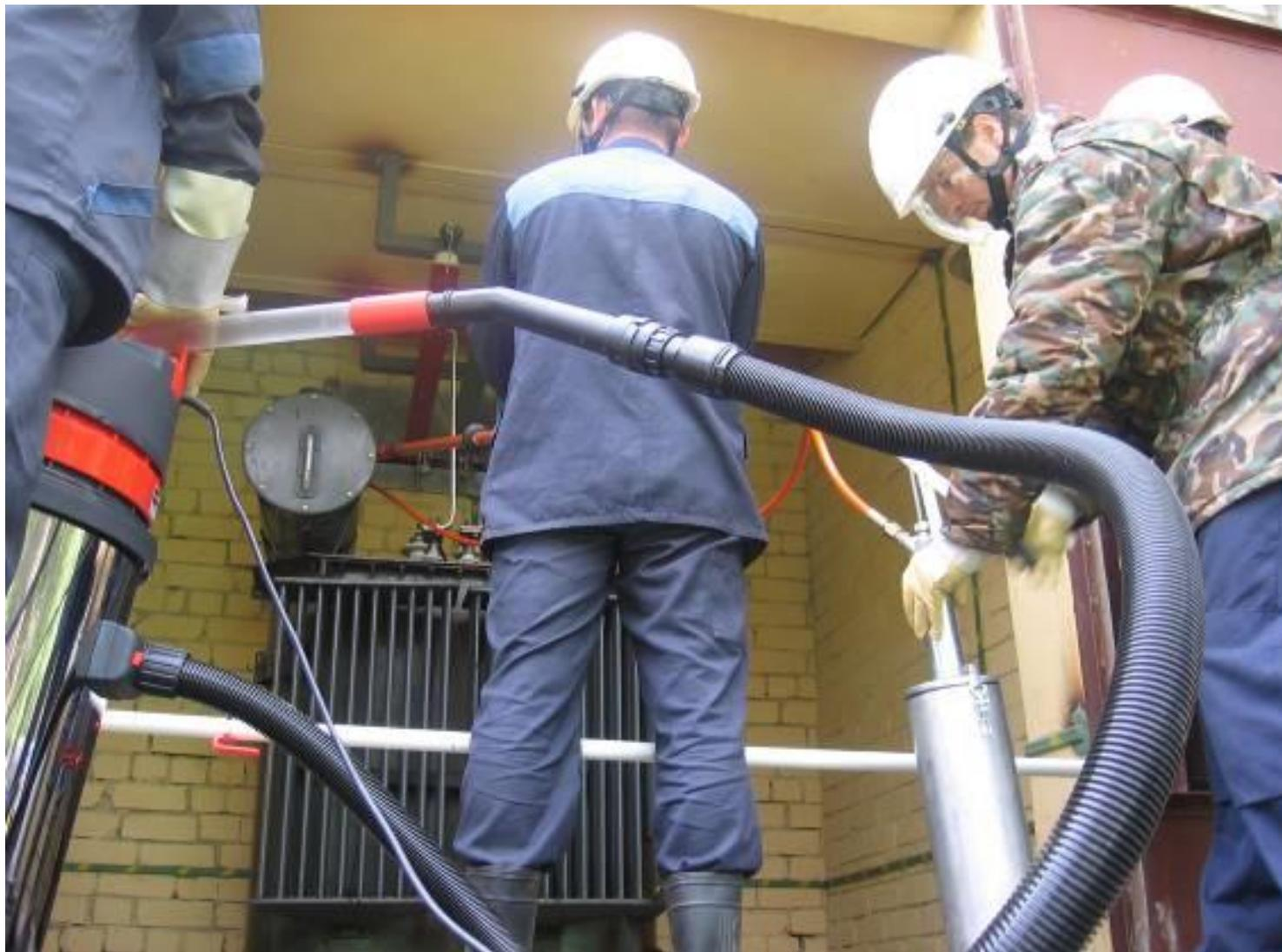
Доливка трансформаторного масла комплектом SE-7
