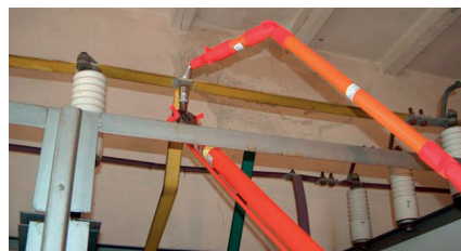
Рис. 20. Подтяжка болтовых соединений в ячейке ТП
