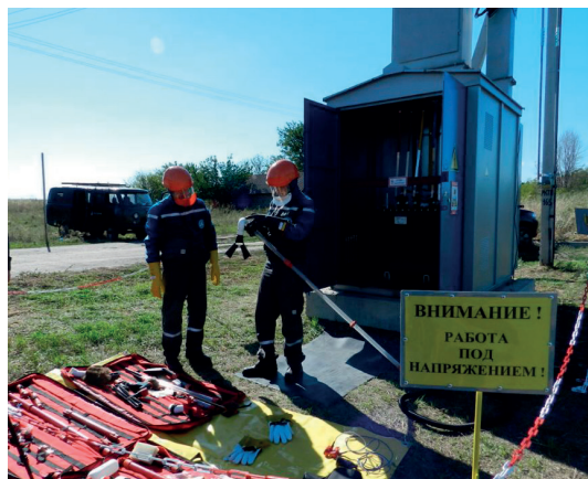
Рис. 10. Чистка трансформатора на действующей ТП-0.4/10кВ «Багаевская», Россети Юг
