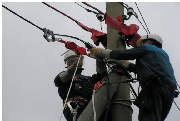
8. Установка зажима на опоре
