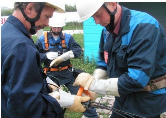
7. Установка зажима на земле
